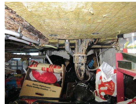
Toiletfaldstamme af støbejern i kæl- der
