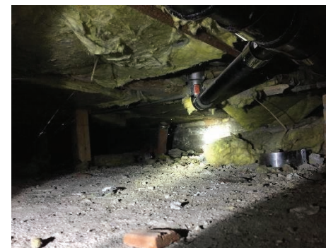
Isolering i krybekælder
