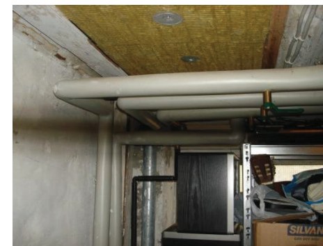
Vandrør i kælder
