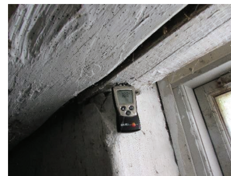
Fugtmåling i kælder
