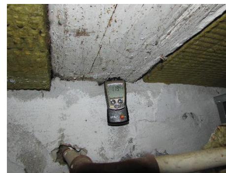
Etagebjælke og rørgennemføring.
