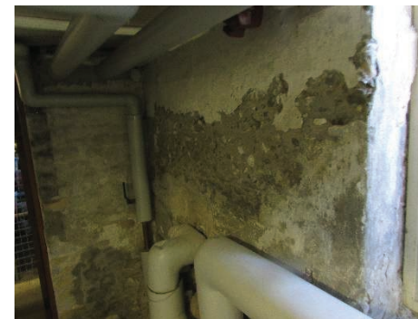
Kældervæg i "murermesterbeton"
