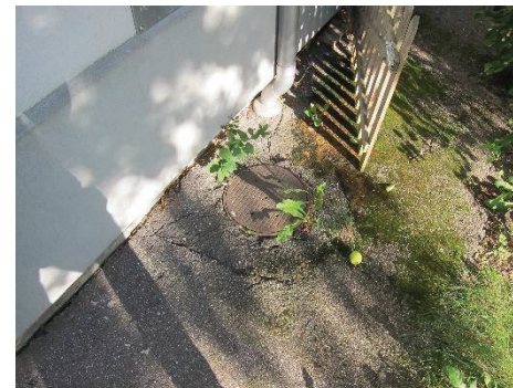
Afklaring af kloak- kernes tilstand kræver en tv- inspektion
