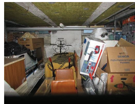
Loft i kælder, isoleret men med synlige bjælker.
