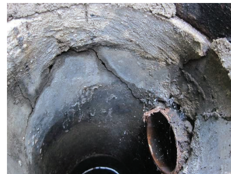
Sprængning af brøndsøjle
