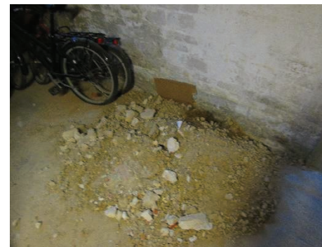
Forsøg med etablering af intern pumpebrønd.
